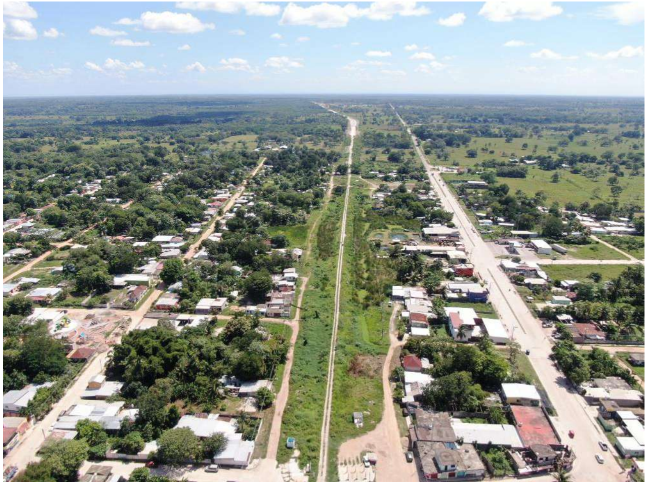
Ilustración 89. Tránsito de la vía férrea en el Triunfo
